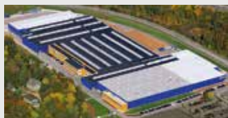
Hörmann KG Eckelhausen, Allemagne
