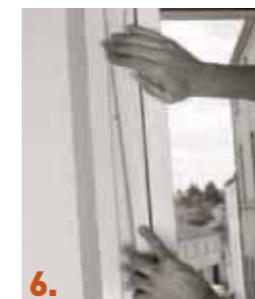
6. Réalisation des habillages intérieurs et extérieurs pour garantir une qualité de finition optimale.
