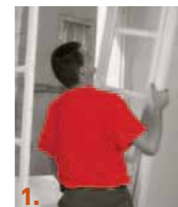
1. Dégondage des ouvrants.
